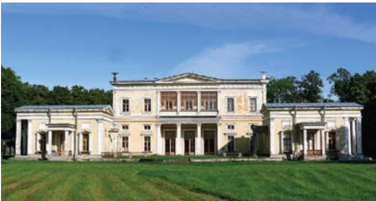
7. Петергофская дорога. Дворец в Сергиевке (южный фасад). Арх. А.И. Штакеншнейдер, 1839-1940.
