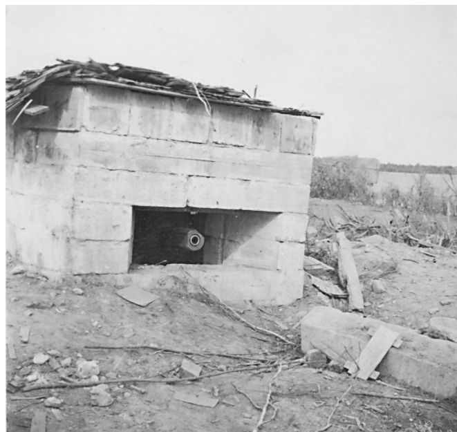
Сборная железобетонная огневая точка с казематной пушкой Л-17 на подступах к Ленинграду, 1941 г.
